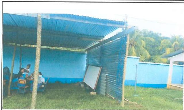
Foto 2: Mejoramiento al módulo tipo pórtico, con medidas de 9x7mts, que corresponde al renglón No. 1.
