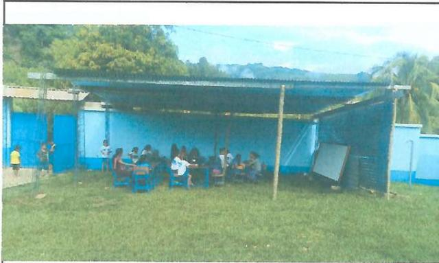
Foto 1: Mejoramiento al módulo tipo pórtico, con medidas de 9x7mts, que corresponde al renglón No. 1.
